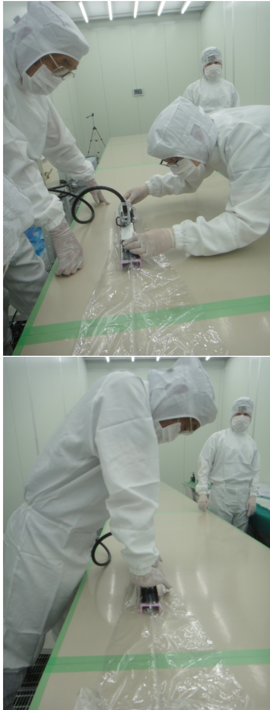
図 7.4: 溶着作業：職人さんの一人が溶着線にあわせて溶着装置をセットし、もう一人の職人さんが溶着を行った
