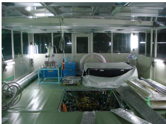
図 8.1: KamLAND ドームエリアに設置されたクリーンルーム
