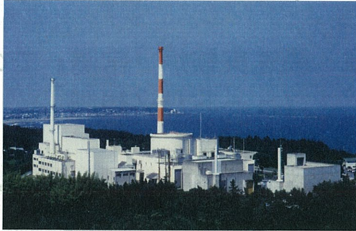
図 6.1: 高速実験炉「常陽」
