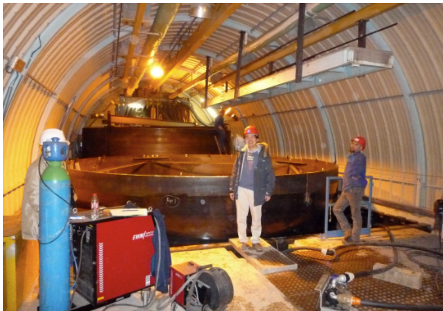
図 26, DoubleChooz 地下実験室。
