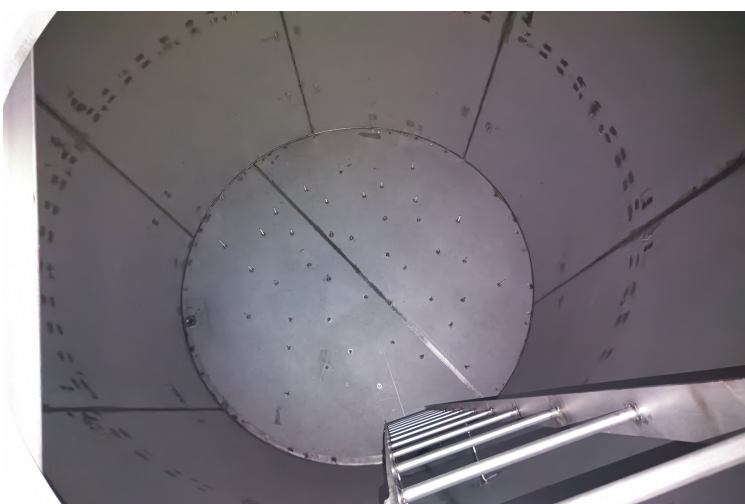
(d) 解体作業完了後のタンク内部
