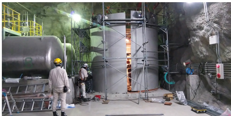
(a) 側面建設中
