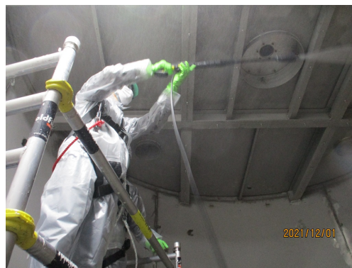
(b) 高圧洗浄機による洗浄
