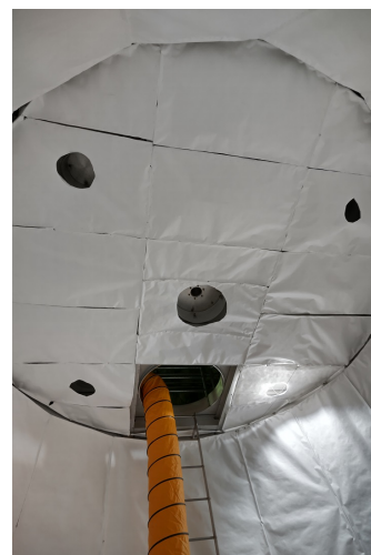
(b) 取付完了時
