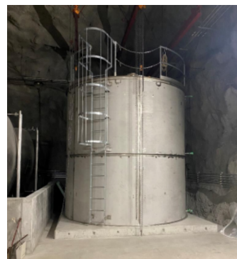
(b) 建設完了時
