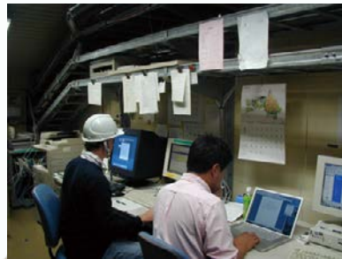
コントロールルーム [5]
