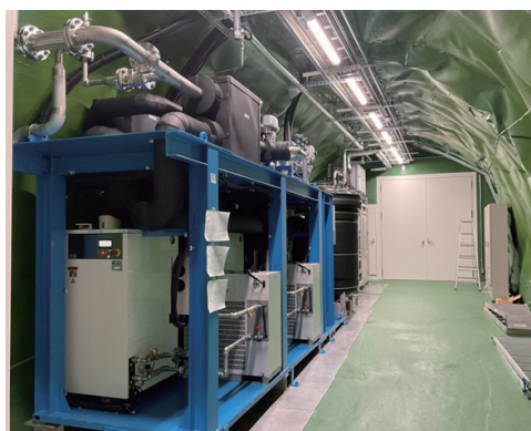
超純空気製造装置（中央に見える黒い筒のところまで）と超純水製造装置（奥）
